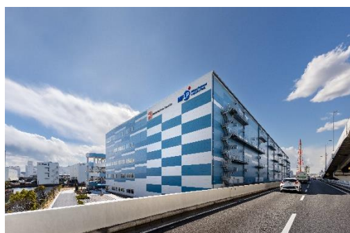
高速道路から見た外観
